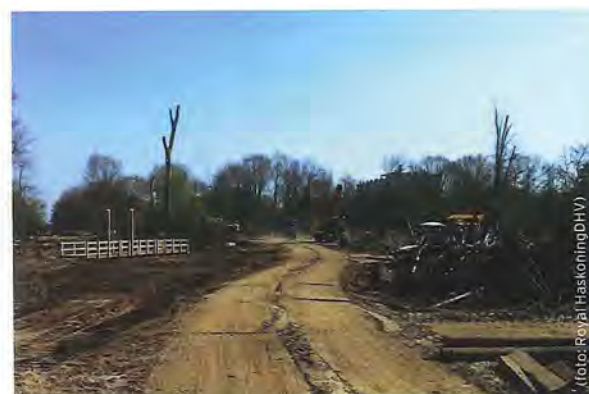
Werk in uitvoering.
